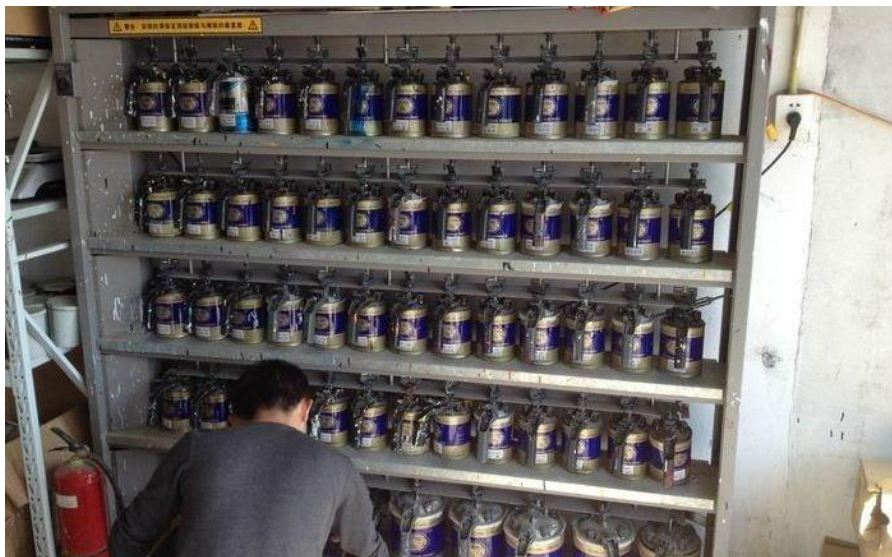
图 2.7 浆盖使用现场图
