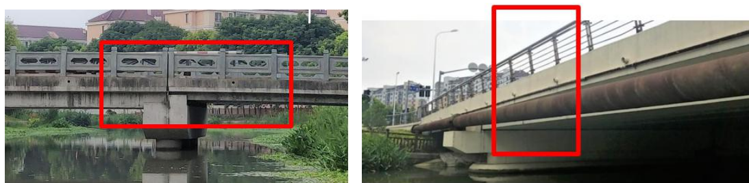
图9 桥梁、道路、堤坝两侧的泄水口
