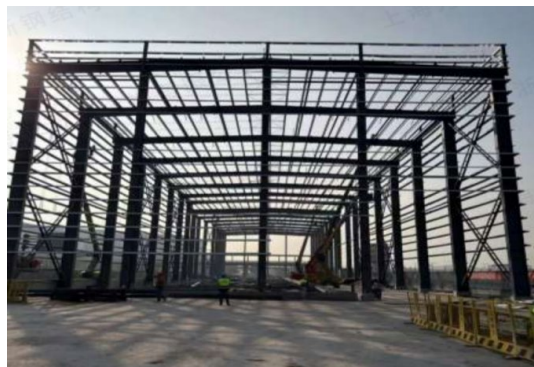
图 7 搭建覆盖钢架施工棚
