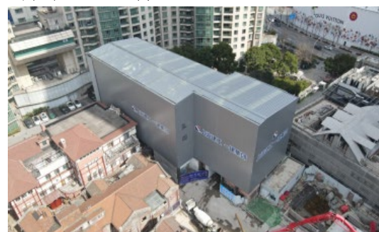
图 8 覆盖法全封闭施工钢结构
