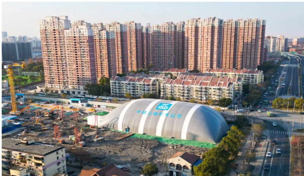
图10 杨浦区某工地采用基坑气膜施工工艺
